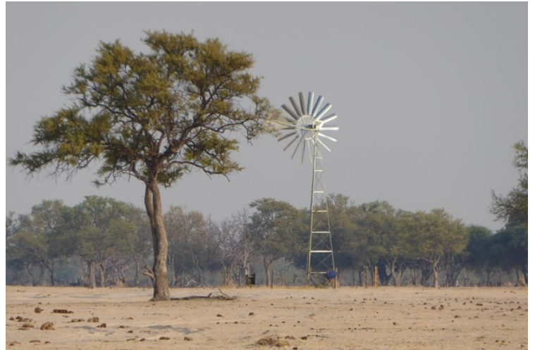
Vi kjører forbi et anlegg for pumping av vann.
