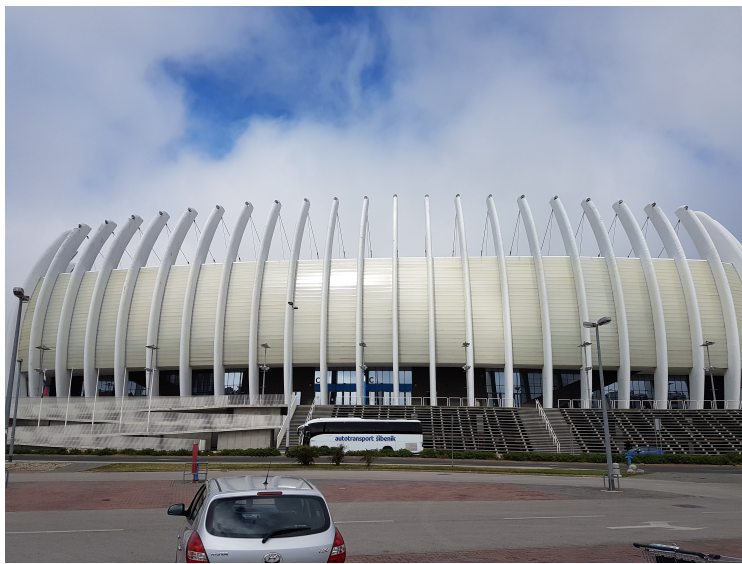
Rett bortenfor hotellet er det et stort idrettsanlegg, Zagreb Arena .
