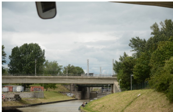
Her nærmer vi oss den øverste slusen. Her skal båten løftes opp fra kanalen, slik at den kan gå ut på Donau.
