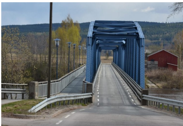
Deretter kjørte vi tilbake til vestsida av Glomma over Sandstadbrua.
