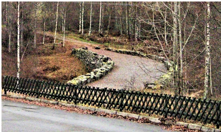
Retten ved siden av ligger denne brua hvor har gått en vei en gang.
