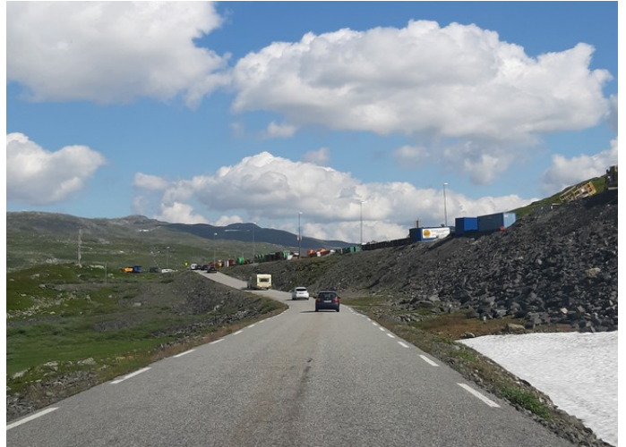
Haukelitunnelen har den østre åpningen til høyre.
