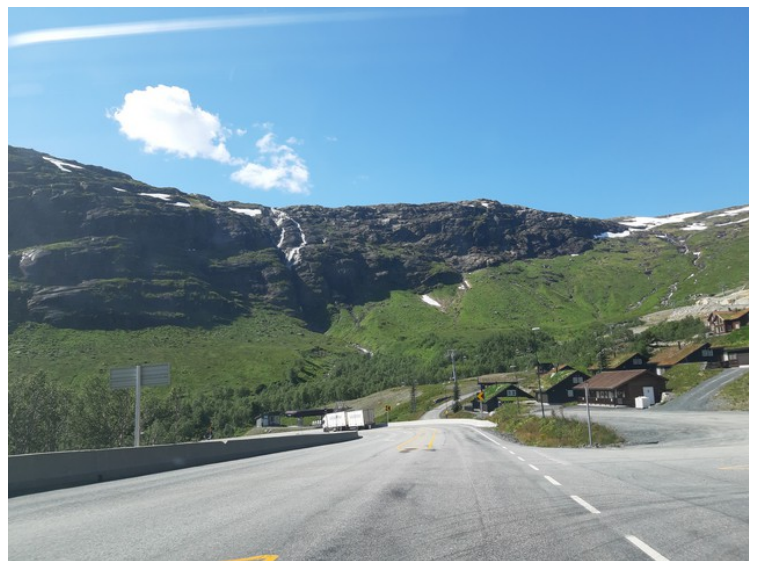
Her har vi kjørt gjennom hele Haugalandet og er kommet gjennom Røldalstunnelen . Den ble åpnet i 1964, og var Norges lengste veitunnel til Haukelitunnelen åpnet i 1968.
