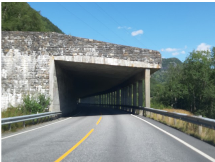
Snøsikring på veien ned til Røldal.
