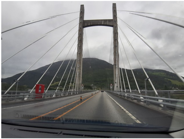
Rett etter tunnelen går det bro over Lågen.
