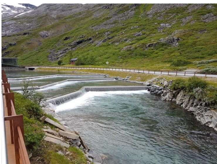
Dammene sett i retning mot besøkssenteret.
