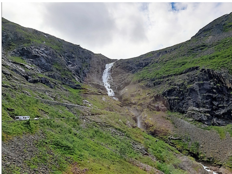
Veien oppover krysser Istra et stykke opp i lia. Her kan vi skimte brua som krysser fossen. Veien har 11 hårnålssvinger og hver sving har navn, oftest etter den arbeidsformannen som hadde ansvaret for denne delen av veien.
