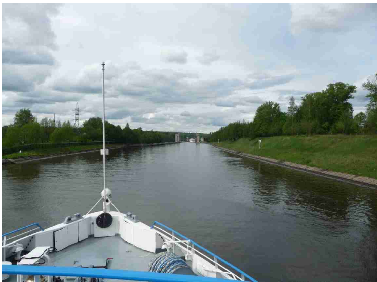
Kanalen er steinsatt på begge sider på mange strekninger.
