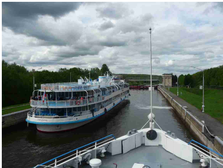
Det er plass til to båter samtidig. Lengden på slusene er 290m og bredden er 30m.
