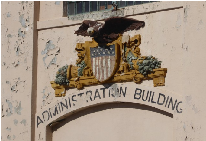
Skilt over inngangsdøra.
