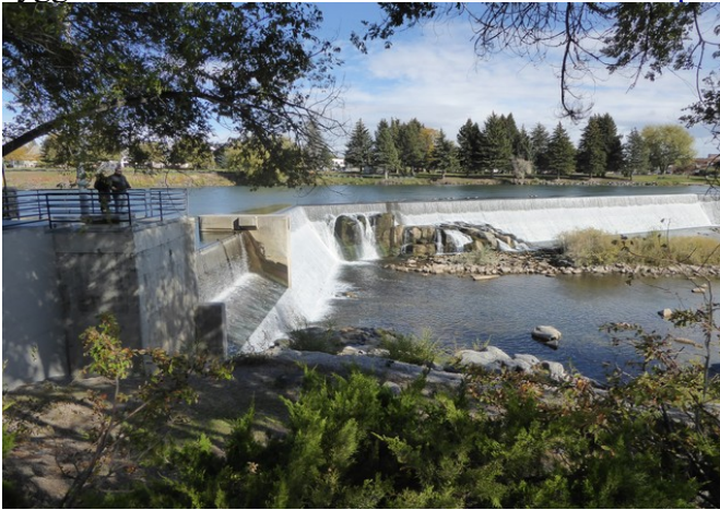
Det er laget en demning i Snake River . Den gir fallhøyde for kraftverket som ligger i enden av demningen.
