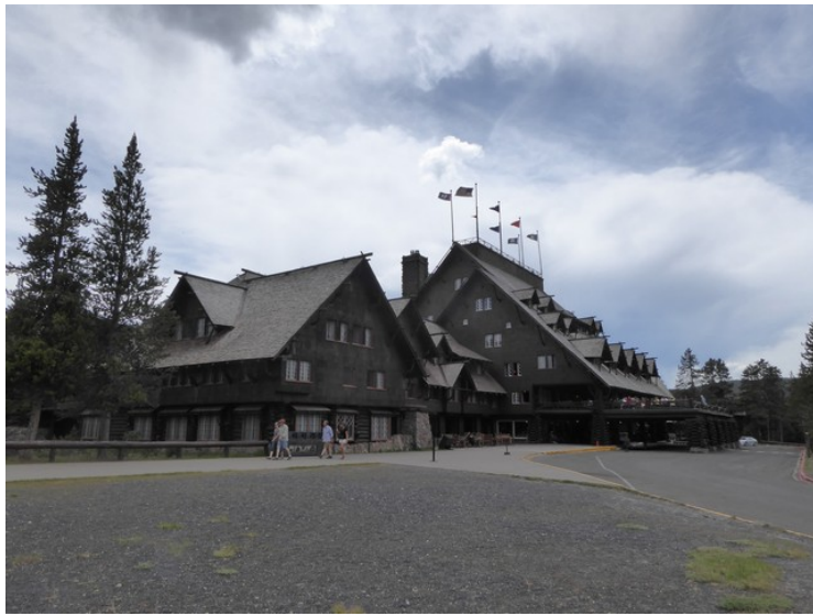
Restauranten og hotellet sett fra andre siden.
