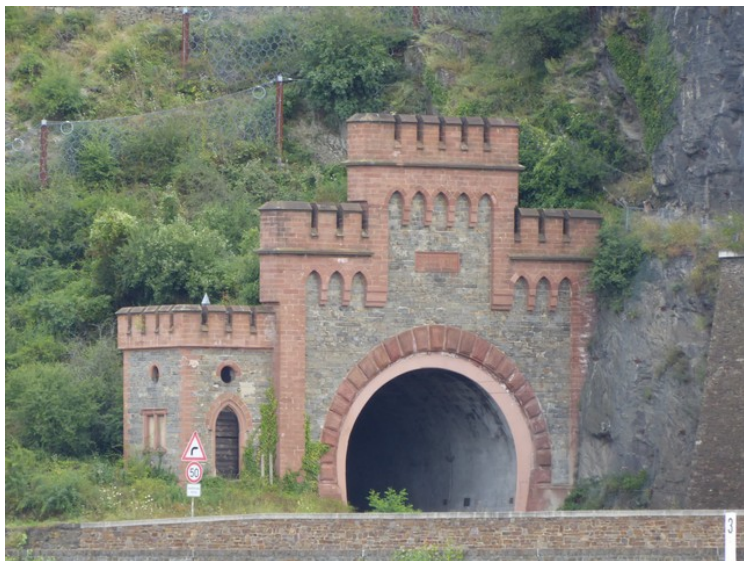
Vi ser tvers over elven på en jernbanetunnel.
