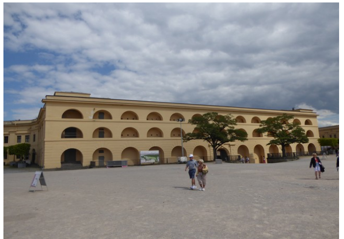
Dette bygget er en del av en ringmur.
