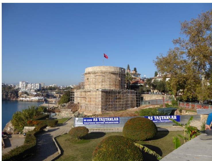
Hidirliks tårn igjen. Det er stillaser rundt hele tårnet, så det er nok restaureringsarbeid på gang.
