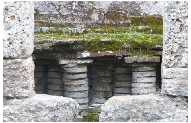
Gulvet var oppbygget på søyler. Slik at varmluften kunne fordeles under gulvet.
