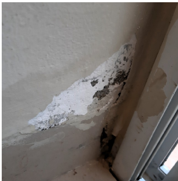
En av manglene var puss som noen steder hadde løsnet fra veggen.
