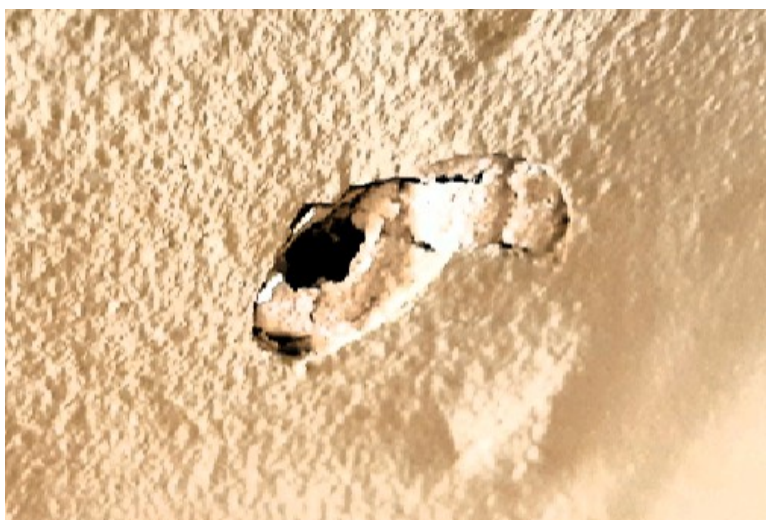
En av manglene var puss som noen steder hadde løsnet fra veggen.
