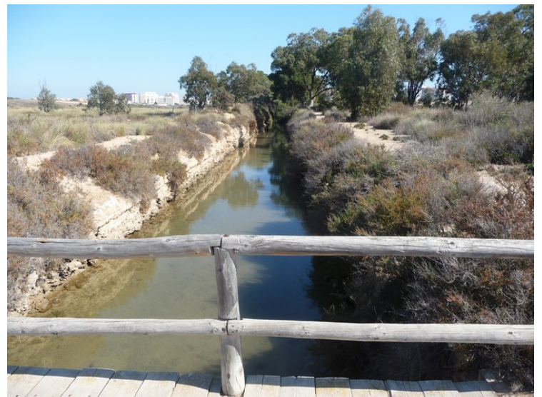
Kanalen går gjennom La Mata i bakgrunnen og ut i Middelhavet.
