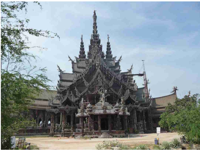
Byggearbeiderne pågikk for fullt.
