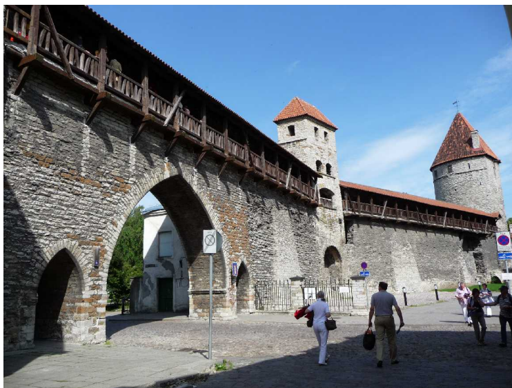
Her er vi kommet til en annen del av muren. Midt på 1500-tallet var hele Tallinn omkranset av en mur som var mellom 2 og 3 meter tykk og over 13 meter høy. Totalt var det 40 forsvarstårn langs muren.
