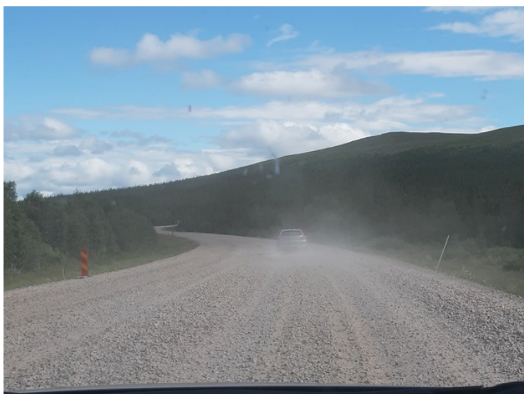
Det var veiarbeid i gang mange steder langs E45, og da ble det å kjøre på grusvei slik som dette.
