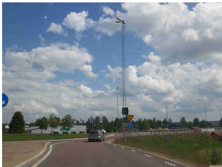
Rundkjøringen i krysset mellom E16 og E45.
