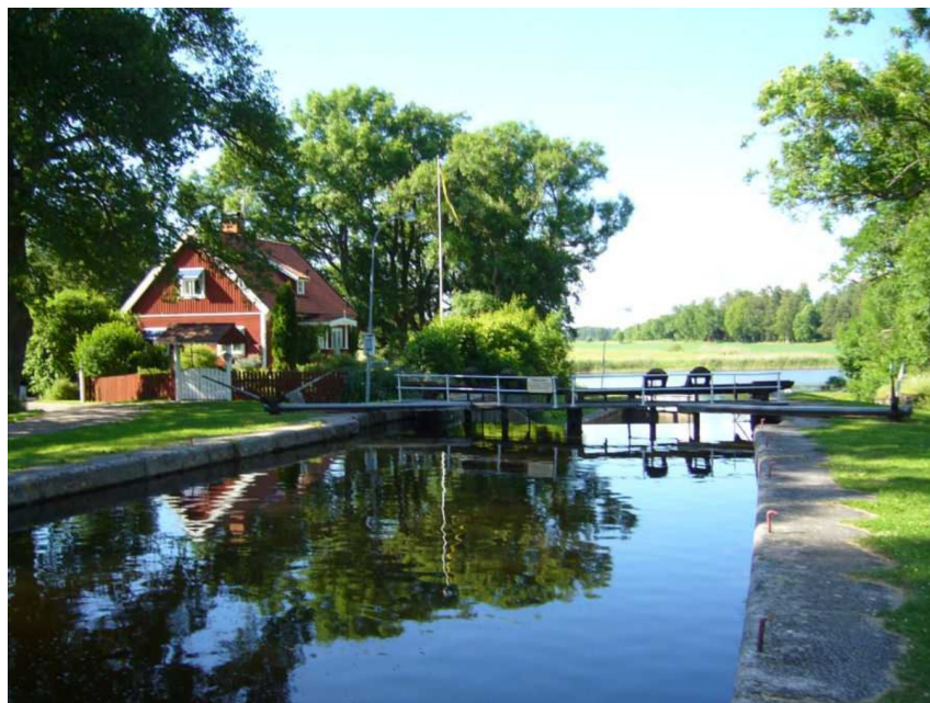
Gravudden-slusene er to manuelt betjente sluser langs Hjälmare-kanalen, De ligger like utenfor Arboga. Slusene forbinder Arbogaån med Hjälmarens og er det nordligste start- eller endepunktet for Sveriges eldste fortsatt seilbare kanal. Det er 9 sluser i kanalen. Via Arbogaån er det videre forbindelse til Mälaren og Østersjøen.
