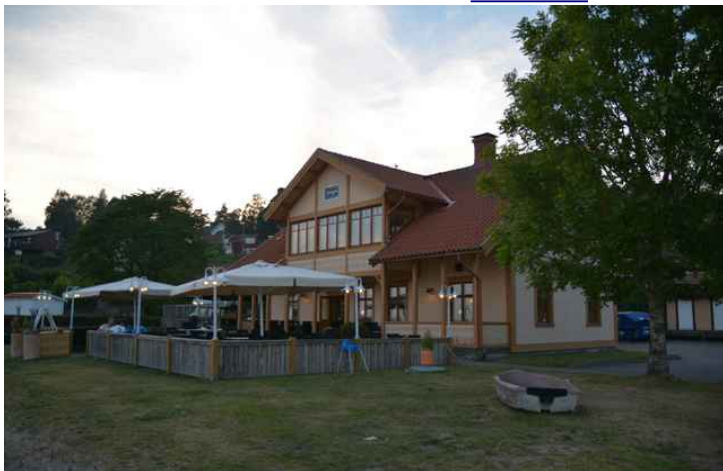
Den gamle Kolmården stasjon på Stavsjö jernbane er nå restaurant.
