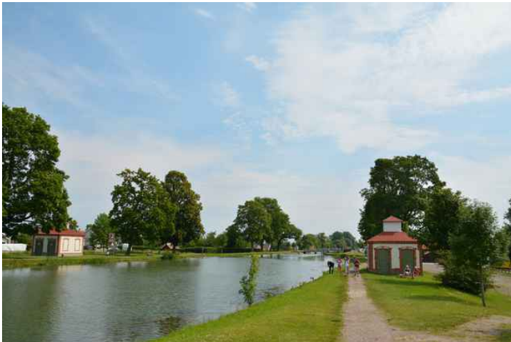
Dette bassenget ligger mellom Oscarsslussen og Karl Ludvig Eugens sluss.
