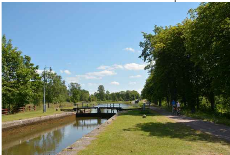
Slusene ved Riksberg .
