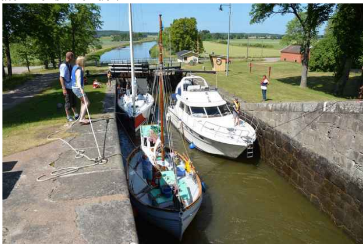
Slusene ved Riksberg.
