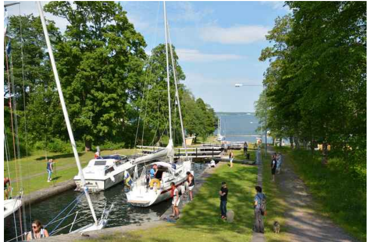
Slusene leder kanalen ned i sjøen Boren .
