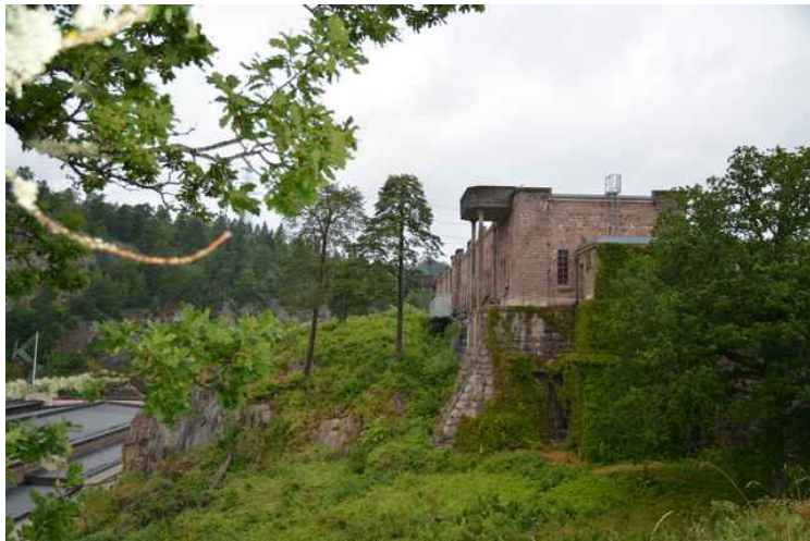
Det øverste bygget på Olidan kraftverk. Olidan var den svenske statens første vannkraftprosjekt. Byggeprosjektet startet i 1905, og de 4 første aggregatene ble tatt i bruk i 1910. I 1921 var den utvidet til 13 aggregat.
