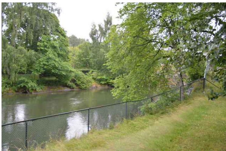
Dette er kanalen som fører vannet bort til Oliden kraftstasjon. Punkt 3 på kartet ovenfor.
