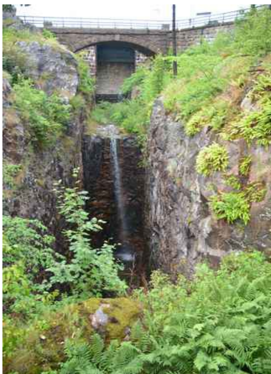
Ved siden av Kongegrotten finner vi den midterste av Polhems tre sluser . Slusen ble ikke gjort ferdig.
