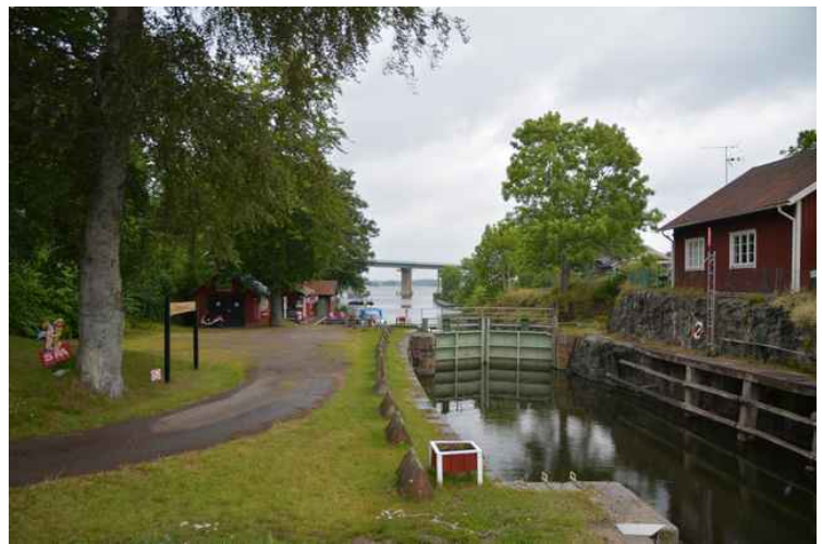
Her er en av slusene. Det er 31 sluser i kanalen. Det høyeste nivået er Stora Le med 102 m.o.h. Link til omtale av kanalen på Wikipedia.
