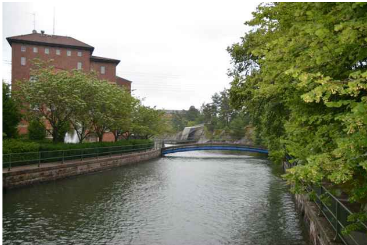
Kanalen som leder ned til Olidan kraftverk. Den går parallelt med og mellom Göta kanal og Göta elv.
