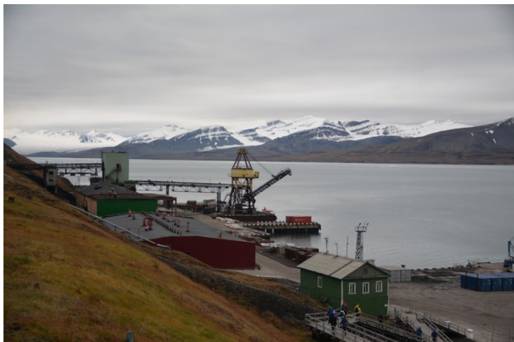
Kaiområdet. Det nærmeste huset er havnekontoret.
