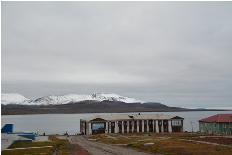
Den gamle kafeteriaen som ikke er i bruk lenger.
