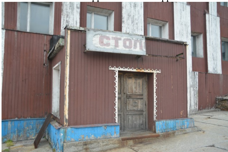
Her var det kafeteria før i tiden. Den er stengt.
