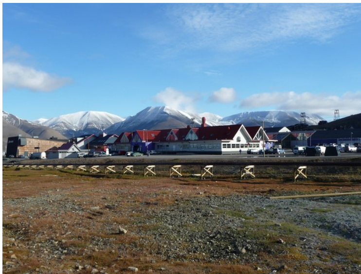
Fjernvarmerørene er lagt i bunn av dalen.
