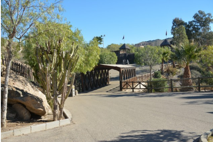
Bru over en ravine.
