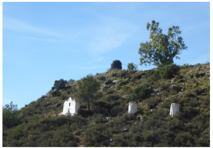
Byggverk oppe i lia.
