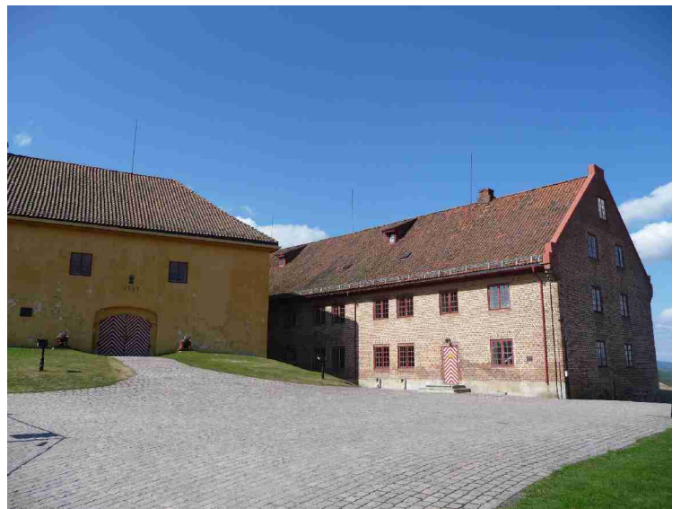
Dette er arsenalet med de gamle barakkene til høyre.
