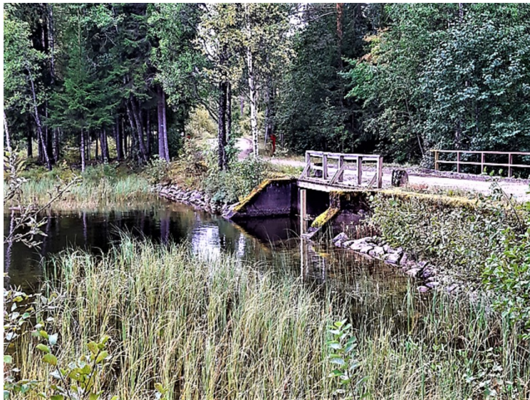
Dette er dammen. Den var stengt. I tillegg er det et overløp under veien hvor vannet dreneres gjennom et stort plastrør.
