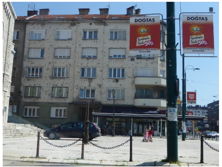
I dette bygget er det fremdeles fullt av kulehull i fasaden etter beleiringen av byen i 1990-årene.
