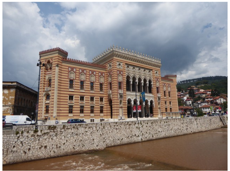
Deretter gikk vi ned til Miljacka for å ta et bilde av det forhenverende rådhuset . Bygget ble veldig skadet under beleiringen i 1990-årene og mye av innholdet og gamle manuskripter ble ødelagt. Bygget er blitt restaurert til en kostnad på over 7 millioner Euro og var ferdig i 2013. Det er nå et nasjonalmonument.
