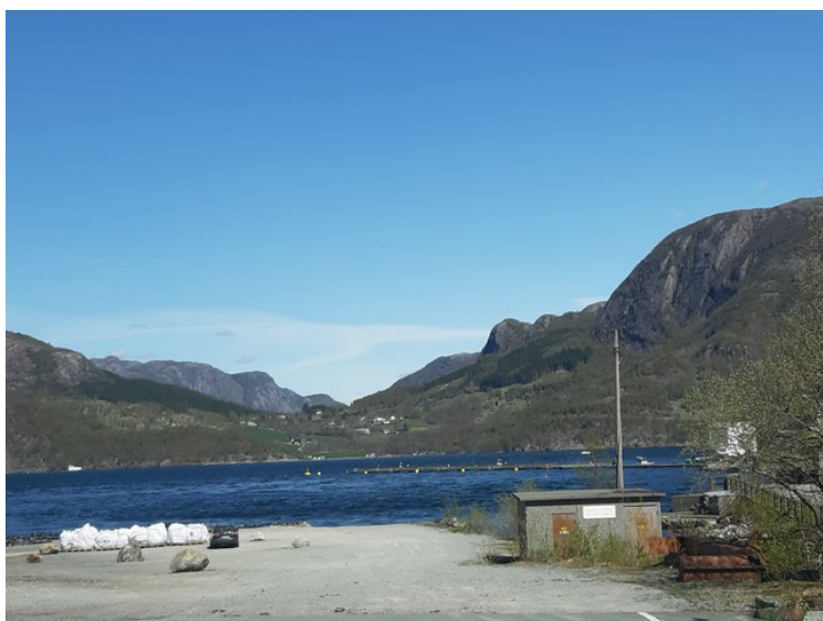
Så var vi nede ved kaien i Oltesvik. Oltesvik Kraftverk ligger ved siden av kaien. Det får vann fra Ragsvatnet, På andre siden av Høgsfjorden ser vi Rossavik.
