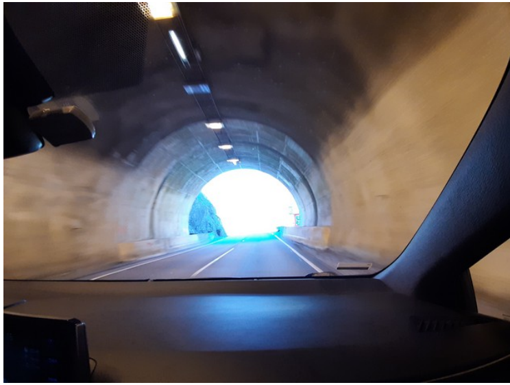
Veien videre nedover dalen går første gjennom Giljajuvet tunnel .
