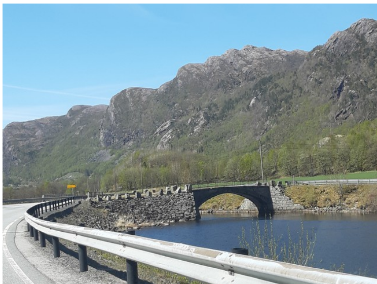
Dette er Rage bru . Den ble tatt ut av bruk i 1937. Herfra kjørte vi en avstikker ned til Oltesvik.
