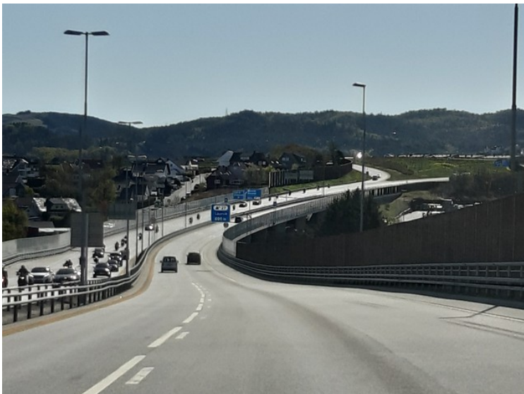
Her går motorveien på Kvelluren bru over Kvelluren i Sandnes.
