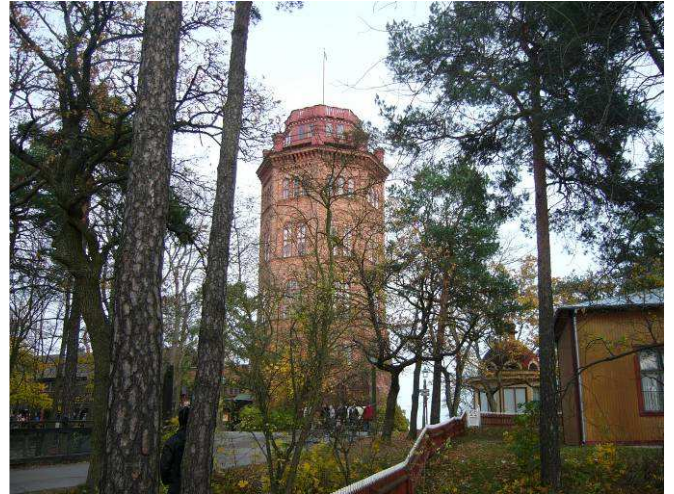
Breidablikktårnet som er 30m høyt. Det ble bygget i 1874-1876 her som det står nå.
