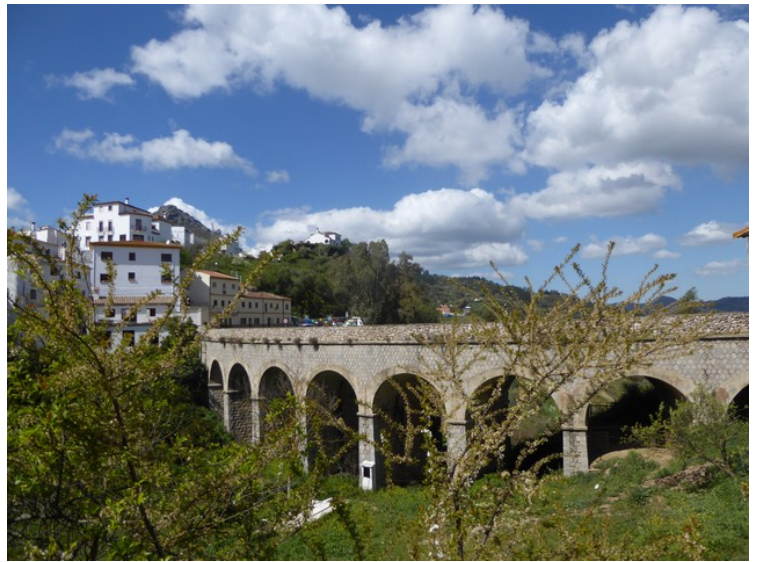
Dette er rett før vi kjører ut på hovedveien igjen. Hovedveien går på denne viadukten.
