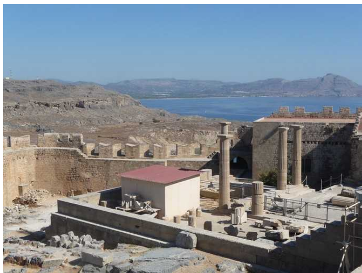
Flere restaureringsarbeider på gang.
