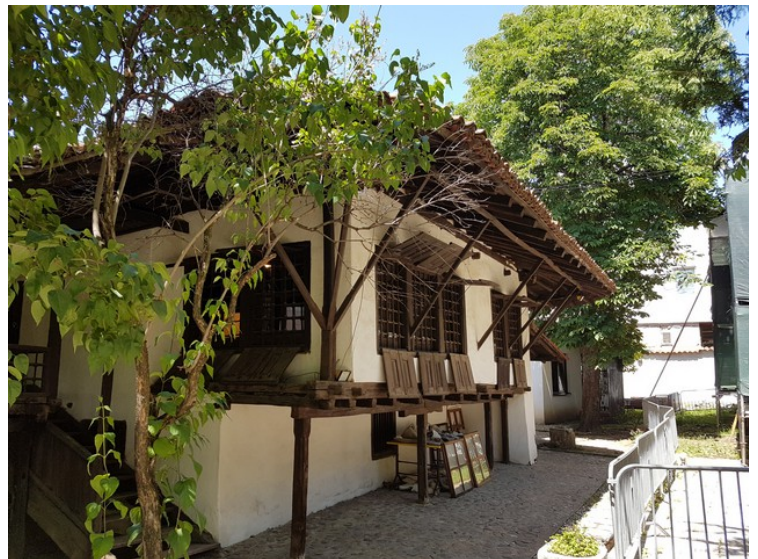
Ett av husene. Andre hus så ut til å være under rehabilitering.
