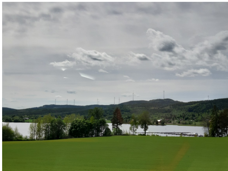
Her ser vi vindturbinene i Odal Vindkraftverk. Den består av består av 23 vindturbiner på Songkjølen og 11 på Engerfjellet.
