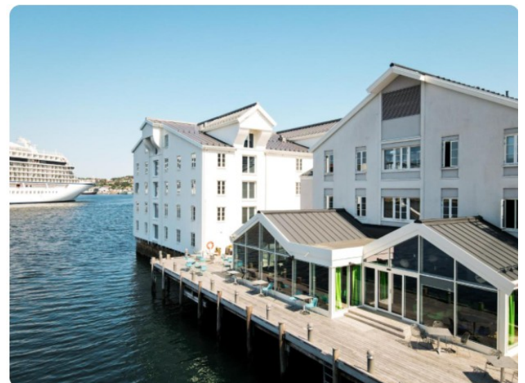
Siste stopp denne dagen var Thon Hotel Kristiansund . Det ligger på øya Innlandet i Kristiansund.
