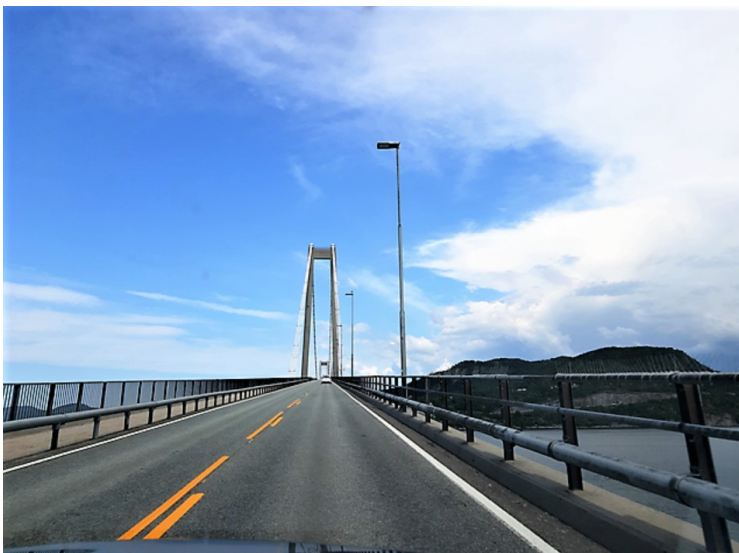
Her er vi på Gjemnessundbrua . Den går over Gjemnessundet fra Gjemnes på fastlandet til Bergsøya.
