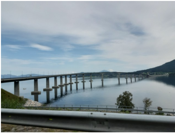
Dette er Tresfjordbrua som går over Tresfjorden fra Remmen til Vikebukta.
