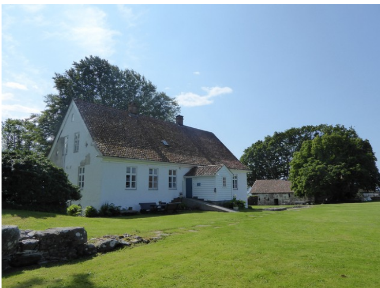
Hovedbygningen sett fra en annen vinkel.
