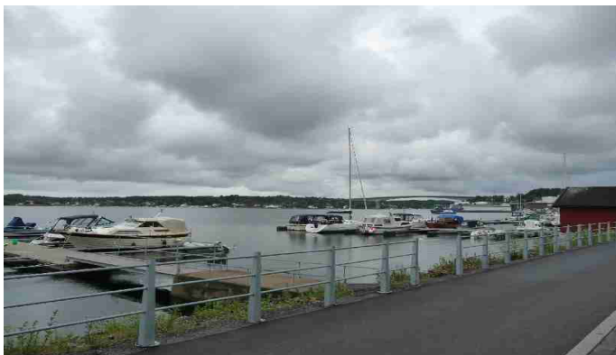
I det fjerne ser vi broen fra Nøtterøy til Tjøme , som ble bygget i 1981.
