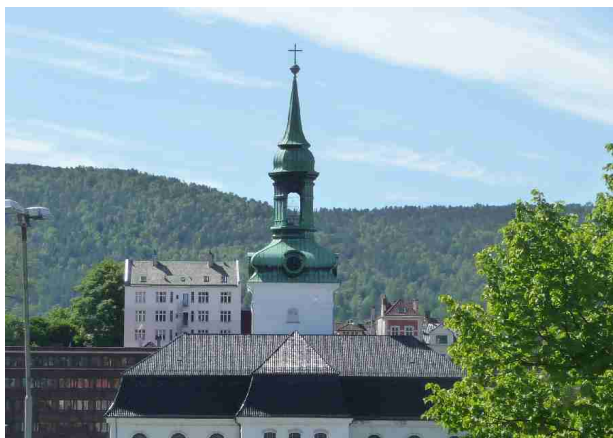
Her ser vi Nykirken tvers over Vågen. Den opprinnelige ble bygget i 1622, men diverse branner og eksplosjoner har ødelagt de forskjellige. Den siste restaureringen ble gjort i 1956.
