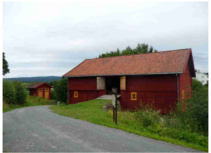
Klokkerlåven ved Tingelstad kirke. En stor del av bygningsmaterialene stammer fra den siste stavkirken på Hadeland, Grinaker kirke.
