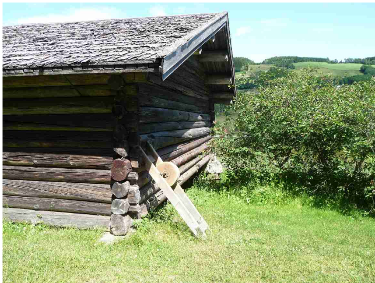
Slipesteinen som ga navnet til Slipsteinsvalseen.
