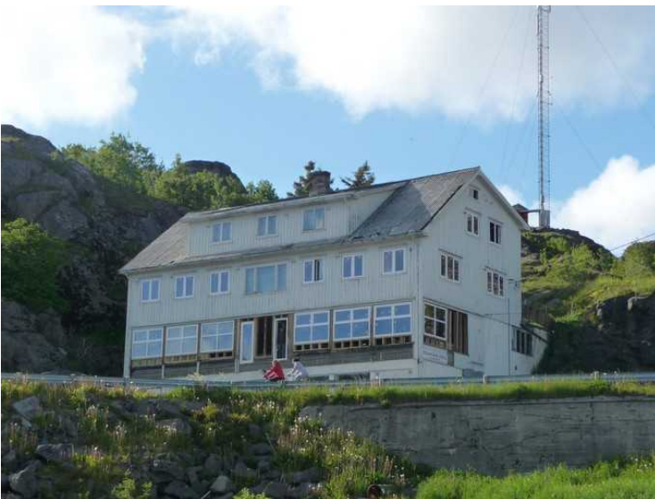
Kjell bodde på dette hotellet i Stamsund da han var på jobb her i 1972. Det er ikke i bruk lenger, men det ser ut til at det er under renovasjon.
