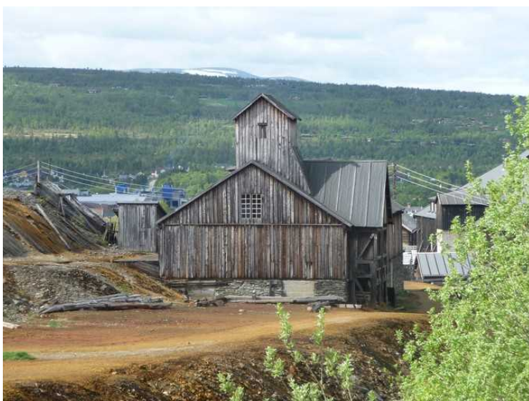
Gamle bygninger på andre siden av Hyttelva.
