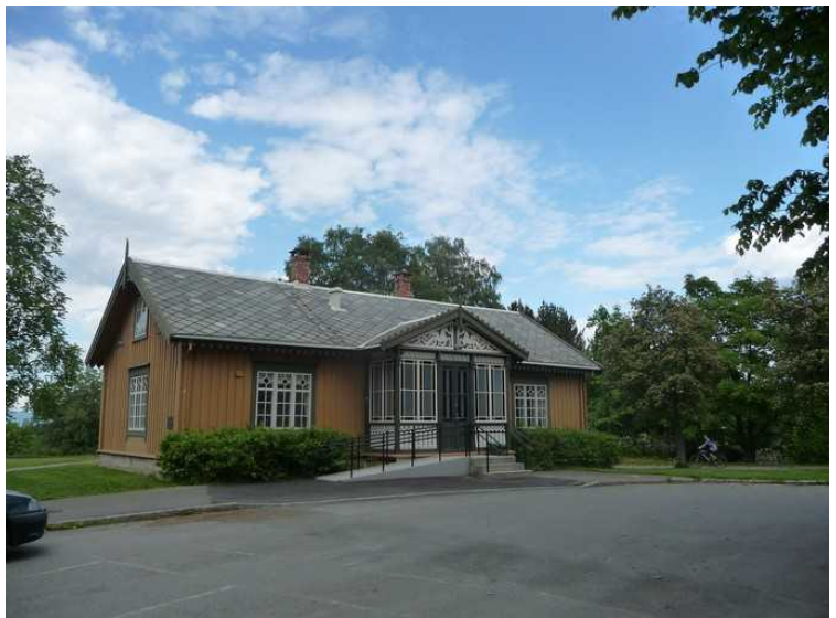
Den gamle bygningen for Tapir bokhandel på NTNU er nå museum. Virksomheten er flyttet til et av sentralbyggene.
