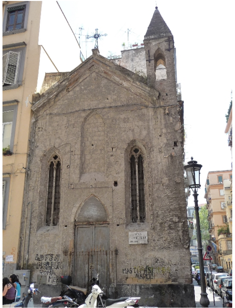
Kirken Santa Donna Regina Vecchia er i nokså dårlig forfatning.
