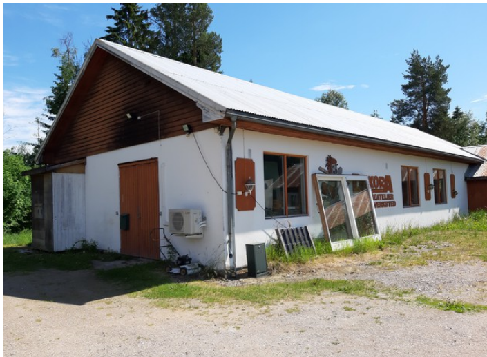
På baksiden av spinneriet er det en bygning som ble brukt som fargereri. Senere har det vært kunstatelier her. Nå står det tomt.
