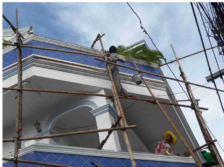
De driver med vedlikehold på en av bygningene på området. De står på dette spinkle bambusstativet.
