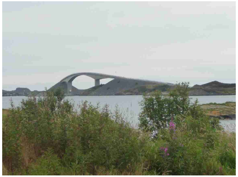
Storseisundet bro er den største og mest kjente av bruene på Atlanterhavsveien.
