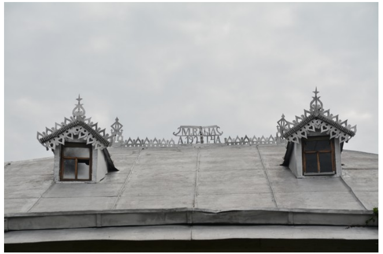
Dette er på taket.
