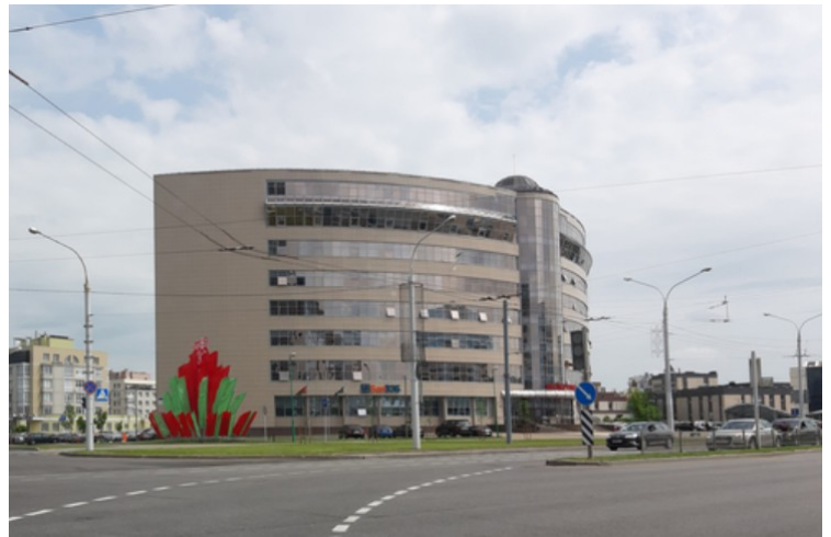
På andre siden av hovedveien ligger et stort bankbygg.
